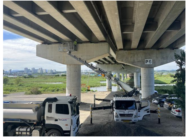
고소차를 이용한 근접조사
